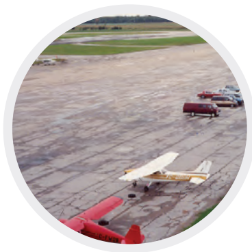
Situation vor Reparatur der Asphaltfläche 1992 - kritischer Zustand
