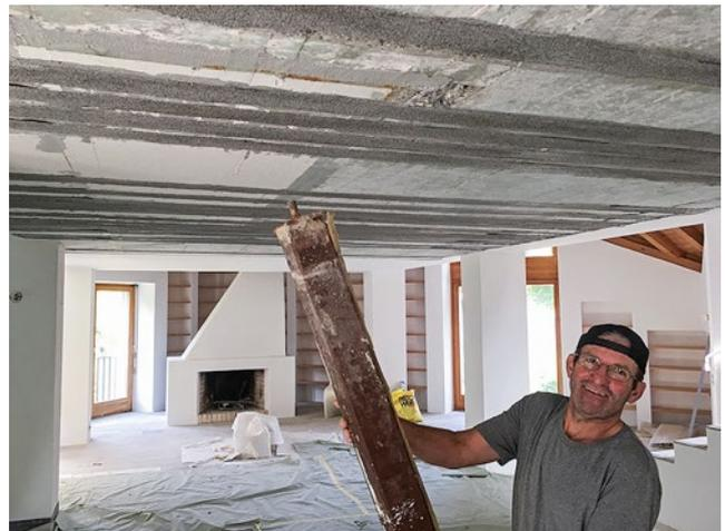
Die Spannweite in der Hauptzugrichtung wird durch Überdrücken einer Dilatationsfuge und entfernen der unterliegenden Stütze verlängert. Das höhere positive Biegemoment sowie die Überdrückung der Fuge wird durch re-plate abgedeckt.
