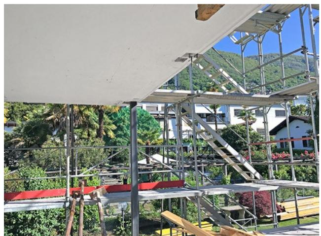
Auf der Balkonoberseite über einer bestehenden Aussenstütze wird das negative Moment verstärkt, damit eine darunterliegende Aussenstütze entfernt werden kann.
