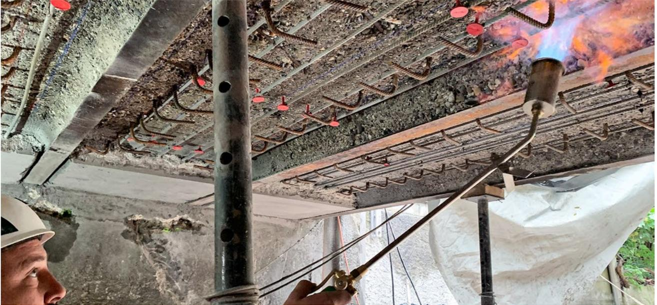
Aktivierung von re-bar mit Gasflamme sowie Temperaturkontrolle
