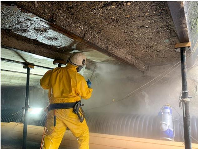
Nach Entfernen der Zwischenwand, provisorisches Abstützen und hydromechanisches Aufrauen
