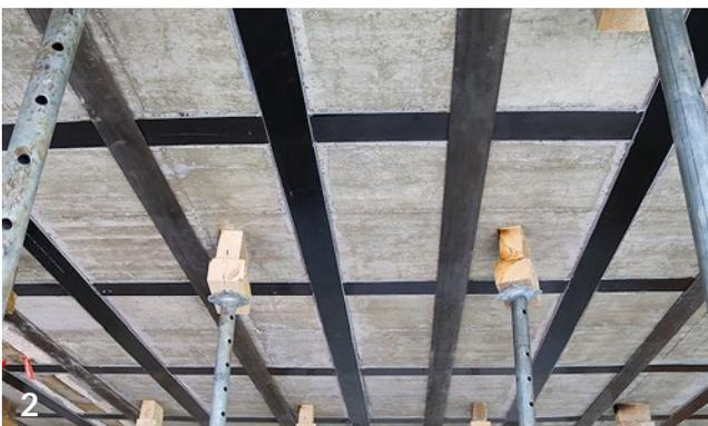
2 Kombination re-plate mit CFK-Lamellen
