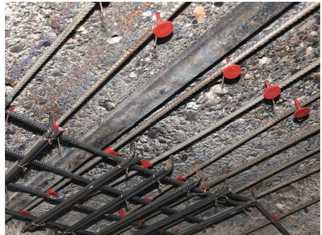
Fixieren von re-bar an Innenbewehrung (re-clip) und am Traggrund (re-bolt)
